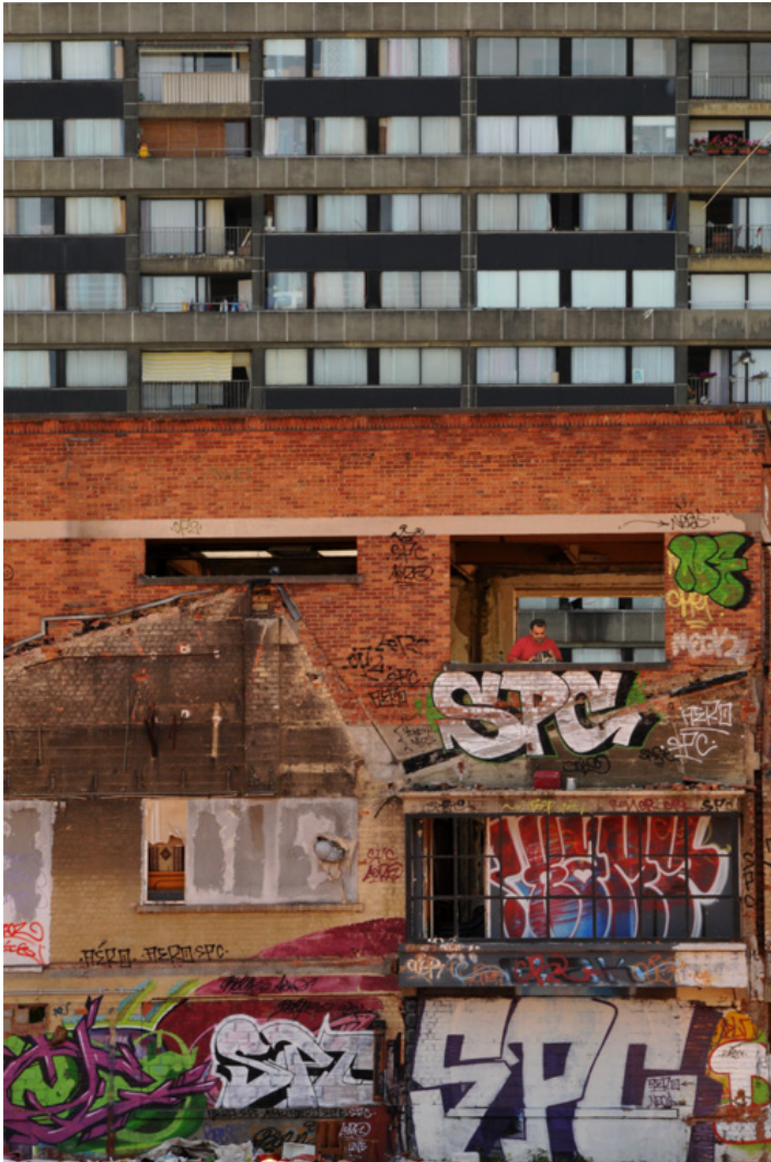
2012 immeuble bâtiment industriel
