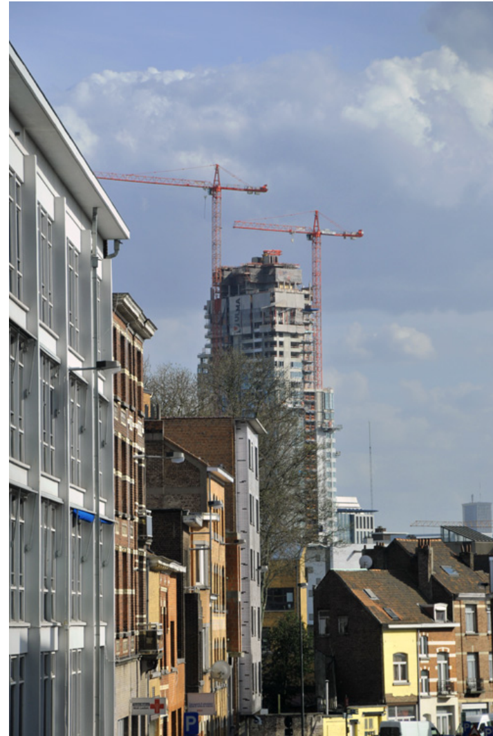
2013 rue tour construction (Laeken)
