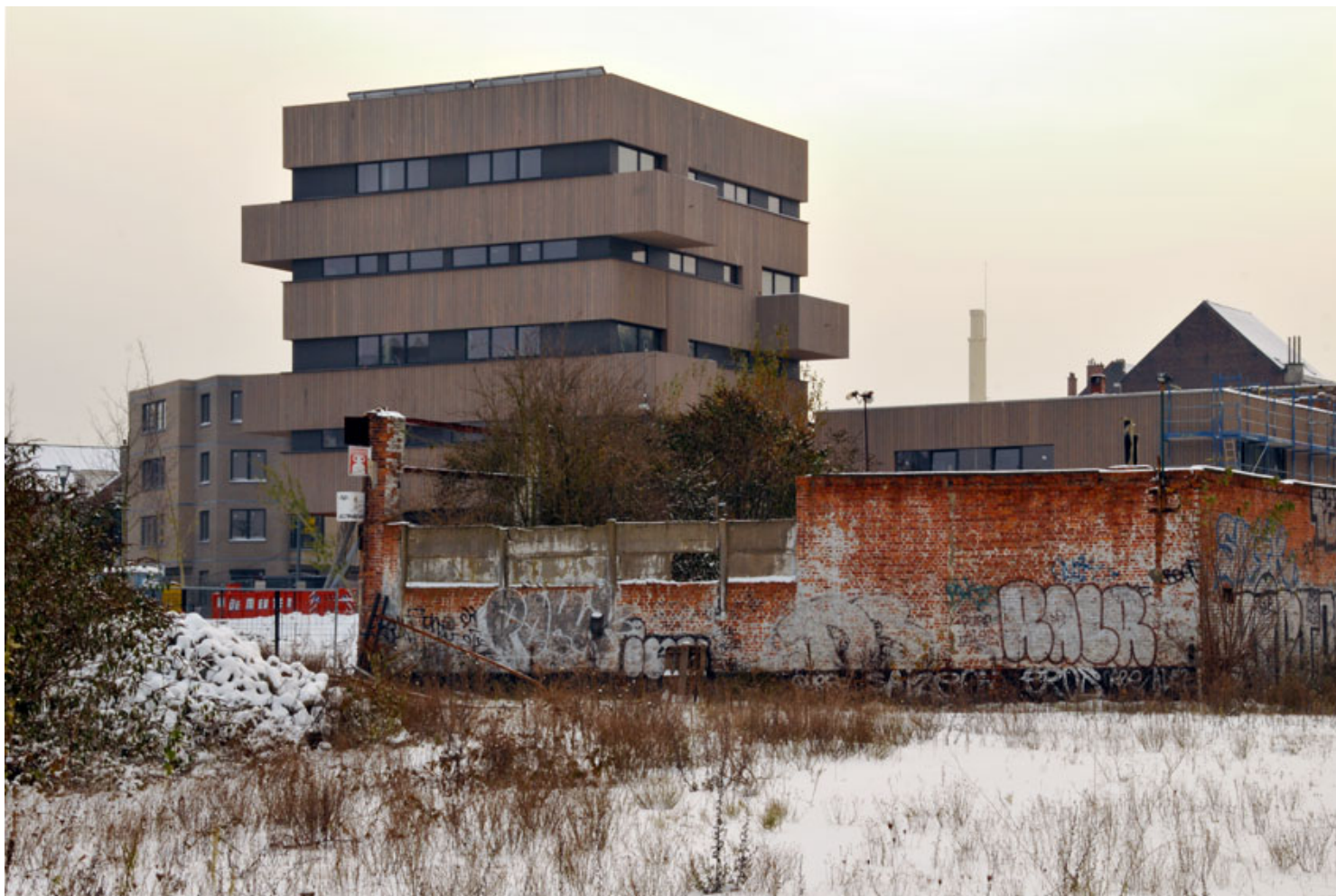
2010 Bâtiment gris neige
