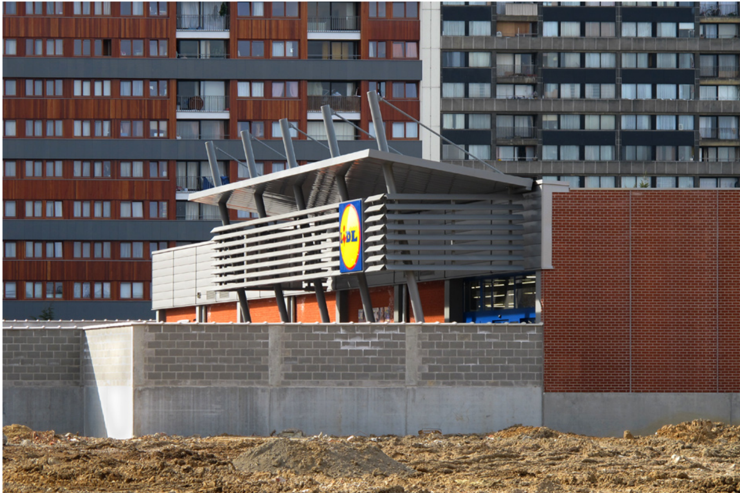
2010 super marché immeuble
